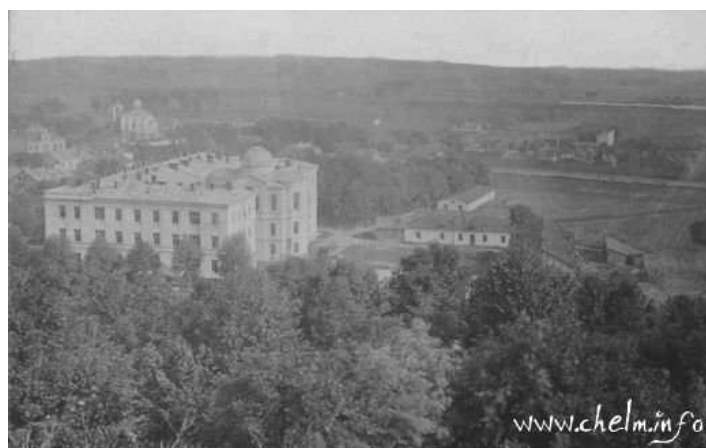
Panorama Chełma z widocznym budynkiem „Czarnieckiego” (w tej części gmachu znajduje się wejście do Gimnazjum nr 2 im. ks. Zygryda Berezeckiego)
