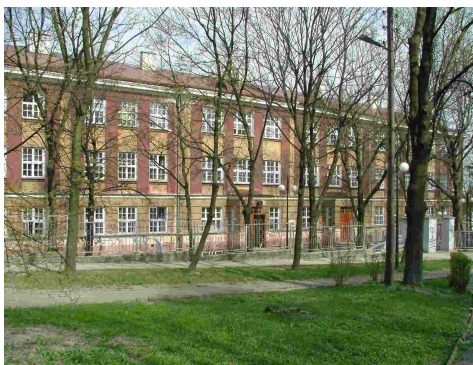
Budynek Szkoły Podstawowej nr 5 im. Marii Konopnickiej w Chełmie
